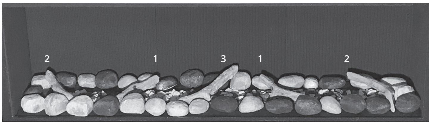
1714RSS—Pierres et gravier installés
